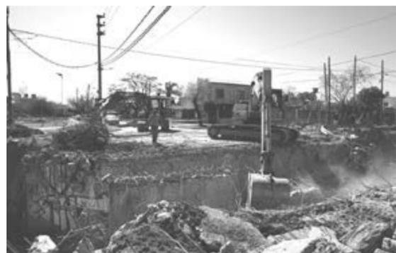
Se realiza con la finalidad de posibilitar el avance del conducto rectangular compuesto por dos celdas, cada una de ellas de 3,50 m de ancho y 1,50 m de altura. A fin de optimizar el trabajo, se procedió a desviar el curso del Arroyo Salguero, el que actualmente corre en forma paralela al antiguo cauce.
