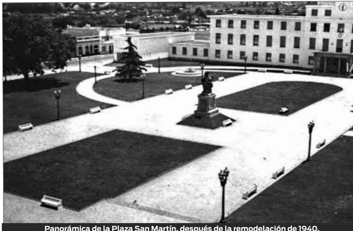
Panorámica de la Plaza San Martín, después de la remodelación de 1940.
